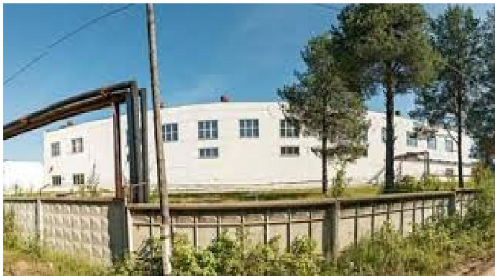
Городской водозабор Сыктывкара расположен в 3,7 километрах выше устья реки Сысола на левом берегу реки Вычегда, в состав которого входят ковшевой и русловый водозабор производительностью 110 тыс. м<sup>3</sup> в сутки и насосная станция первого подъёма мощностью 105 тыс. м<sup>3</sup> в сутки. Исходная вода по трём водоводам подаётся на водоочистные сооружения в м. Красная Гора.
